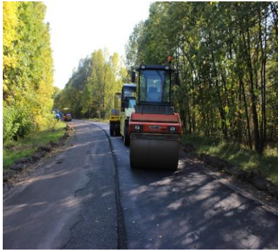
Будівництво доріг в районі
