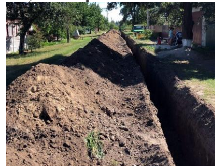
Будівництво водогону в м. Корюківка
